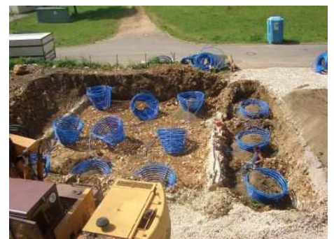
Einbau einer Erdwärmekorbanlage
