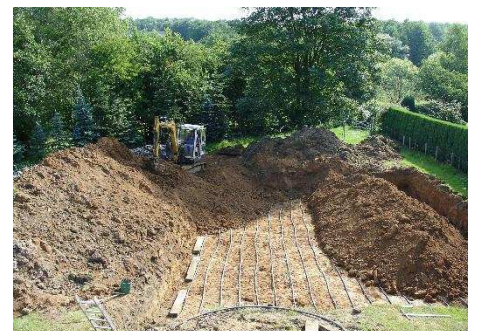
Verlegung eines herkömmlichen Flachkollektors
